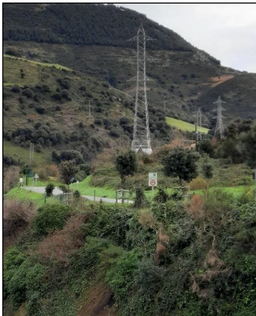
Fotografía 25. Vegetación a talar (avellanos) bajo la línea y junto a la carretera en el vano 16-17 y vista del apoyo 16. Al fondo apoyo 15.
